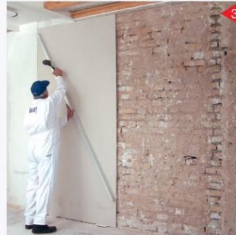
استفاده از شمشه فلزی و چکش پلاستیکی جهت قرار گرفتن صفحه در جای خود مطابق خطوط راهنمای کف و سقف
