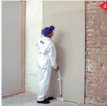
استفاده از چک نگهدارنده برای ثابت نگه داشتن صفحات تا زمان گیرش خمیر پرفلیکس
