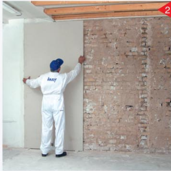
نصب صفحات با توجه به خطوط راهنمای اجرا شده در کف و سقف
